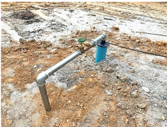
งานขุดเจาะบ่อบาดาล
