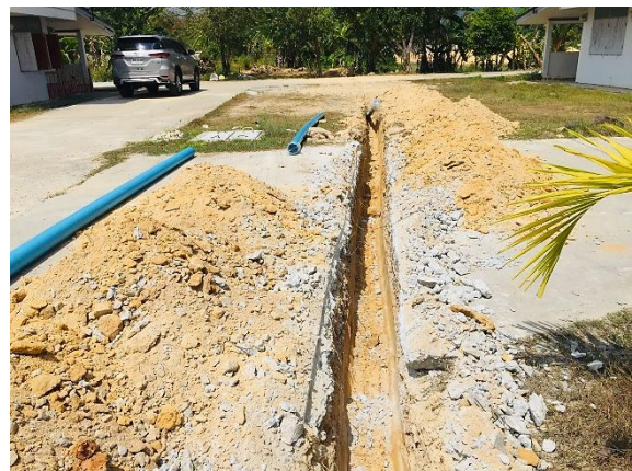
งานปรับปรุงระบบโครงข่ายท่อส่งน้ำหลัก
